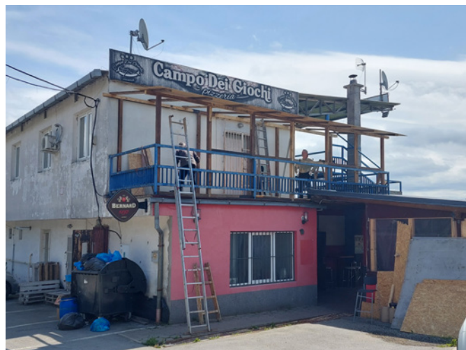
V interiéri aj exteriéri reštaurácie prebiehajú rekonštrukčné práce
